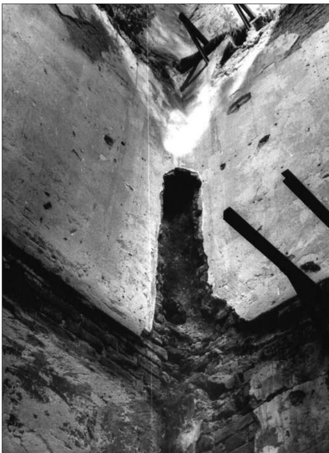
Рис. 1. Остатки отопительной системы в башне замка G. Wohnsdorf/Курортное (архив автора).
